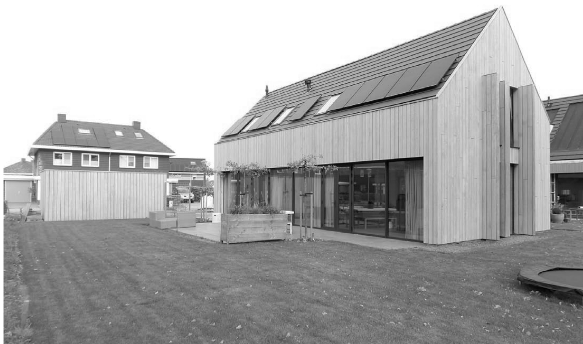
6. De westelijke langsgevel is aan de terraszijde volledig open. Op het dak de grote dakvensters die in lijn met de zonnepanelen lopen.
